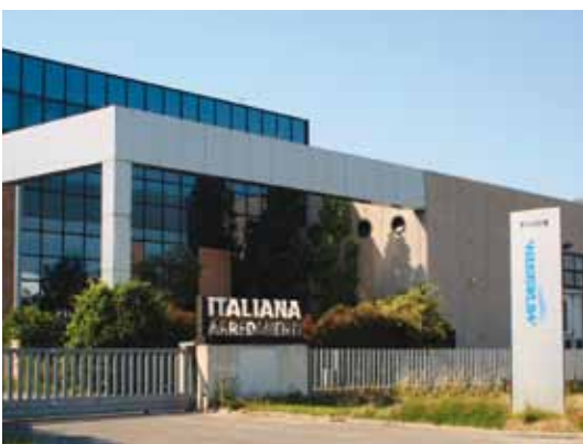
stabilimento di Parma / Parma plant
