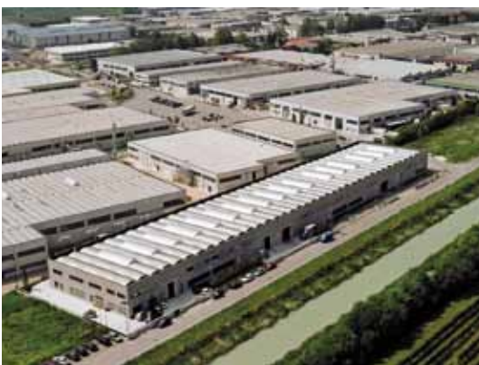
stabilimento di Motta di Livenza (VI) / Motta di Livenza (VI) plant
